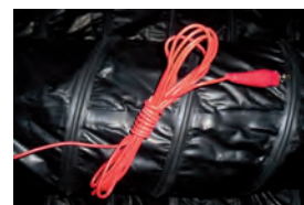
Versehen mit Erdungsleitungen an jedem Ende
